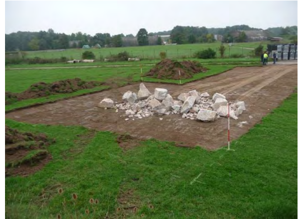
Foto 2: Oberboden Abschälung südlich der Schießsportanlage (Aufnahme Sept. 2013).
