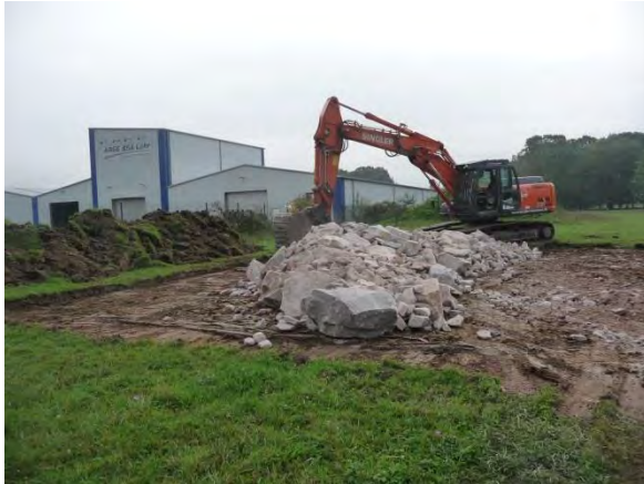
Foto 1: Oberboden Abschälung nördlich der Schießsportanlage (Aufnahme Sept. 2013).
