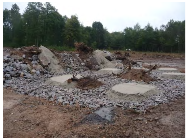
Foto 6: Einsatz von Wurzelstöcken, Anlage im Südosten (Aufnahme Okt. 2013).
